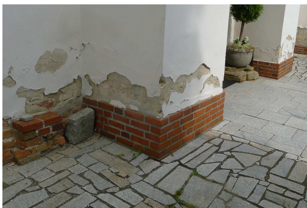
Fot. 6: Zawilgocenie przyziemia muru - widoczne odspojenie tynku
