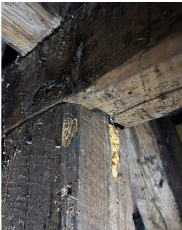
Fot. 14: Słupek więźby nad prezbiterium, ślady żerowania larw spuszczela
