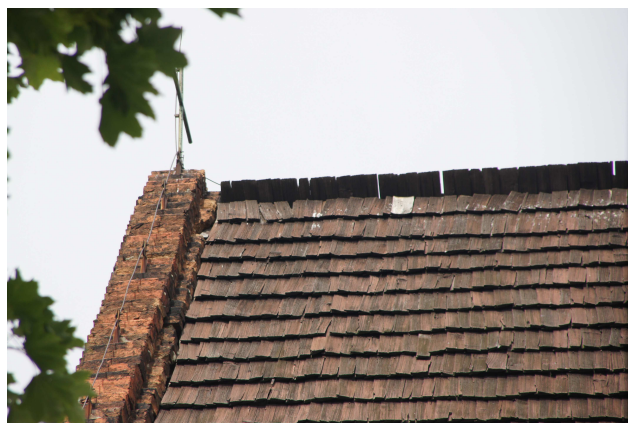
Fot. 5: Gontowe pokrycie dachu - widoczne nieszczelności i wadliwy sposób położenia, z pozostawieniem szczeliny na styku muru i połaci
