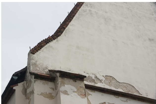
Fot. 4: Odspojenie i zawilgocenie tynku szczytu zachodniego
