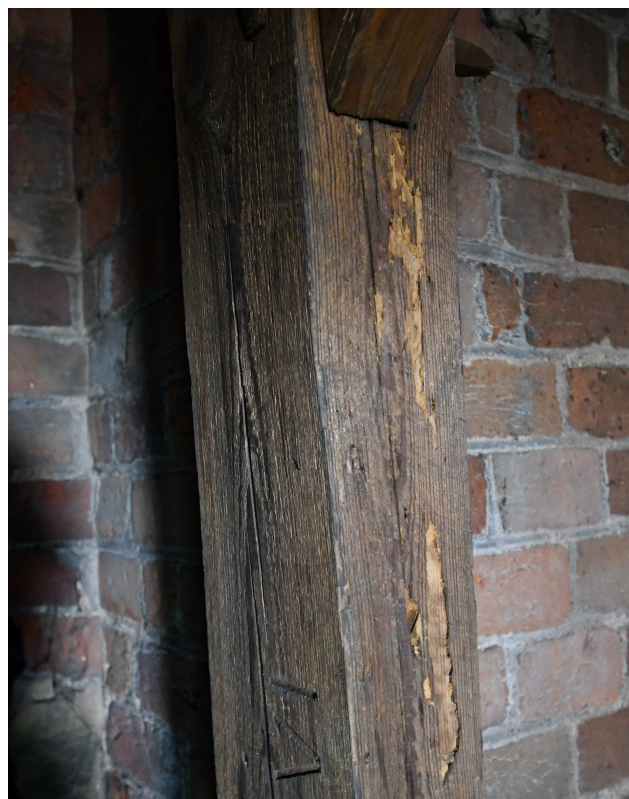
Fot. 15: Słupek więźby nad prezbiterium, ślady żerowania larw spuszczela
