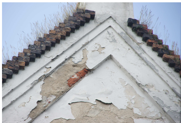
Fot. 9: Ślady zawilgocenia szczytu wschodniego prezbiterium
